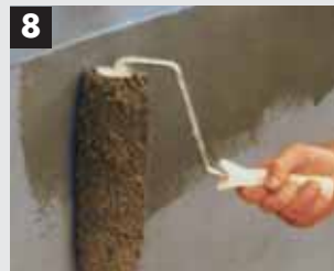
8 Dubbele verflaag met KEIM Concreton-C. Tweemaal onverdund aanbrengen met een borstel, roller of airless spuit.
