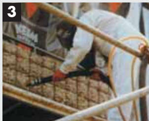
De wapening wordt gereinigd door droogstralen met vaste straalmiddelen, ontroestingsgraad Sa 2 1/2 volgens DIN EN 12944-4
