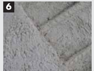
6 De gaten opvullen met minerale KEIM Concretal-Mortel-R in de vochtige hechtbrug. Laagdikten van 0,5 – 5 cm mogelijk. Vanaf ongeveer 2,5 cm in meerdere lagen aanbrengen.
