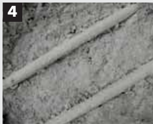
4 Dubbele beschermingslaag op het ontroeste staal met KEIM Concretal-MKH. Droogtijd minimaal 3 uur. Eerste laag wordt onmiddellijk na het ontroesten aangebracht.
