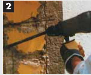
2 De aangetaste wapening wordt vrijgemaakt
